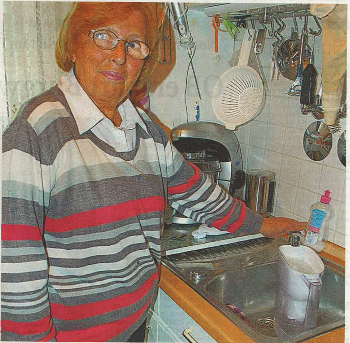
Rita Hallof in ihrer Küche. Vor einem Jahr musste hier eine undichte Leitung ersetzt werden. Nun fragt sich die Stadtbau-Mieterin, weshalb nicht der Rest der Leitungen auf dieselbe Weise ausgetauscht werden kann. Fotos: ht
