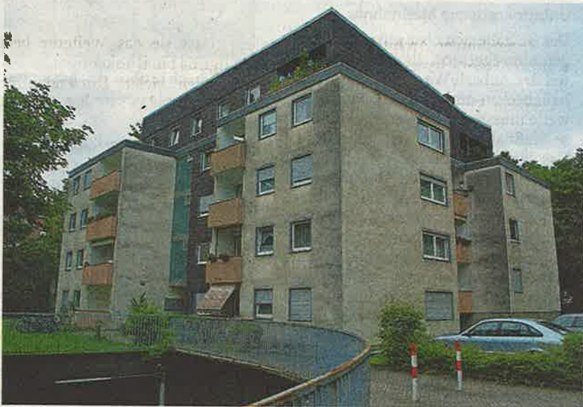
Der Stadtbaublock in der Lilienthalstraße, in dem das Wasserrohrnetz ersetzt werden soll. In dem System vermehren sich immer wieder Legionellen.
