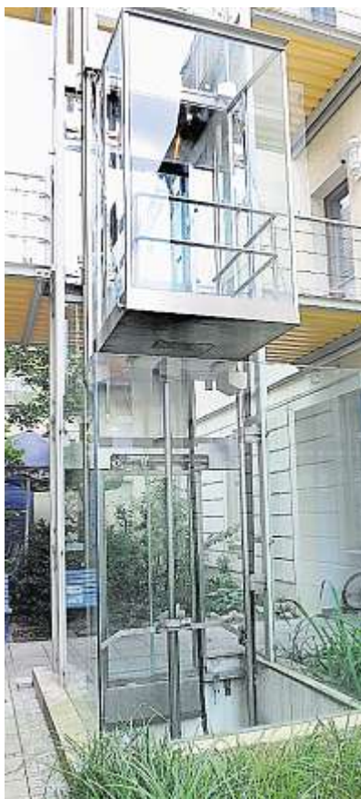
Der Bau eines neuen Aufzugs in der Fidelgasse könnte sich bis 2015 ziehen.
