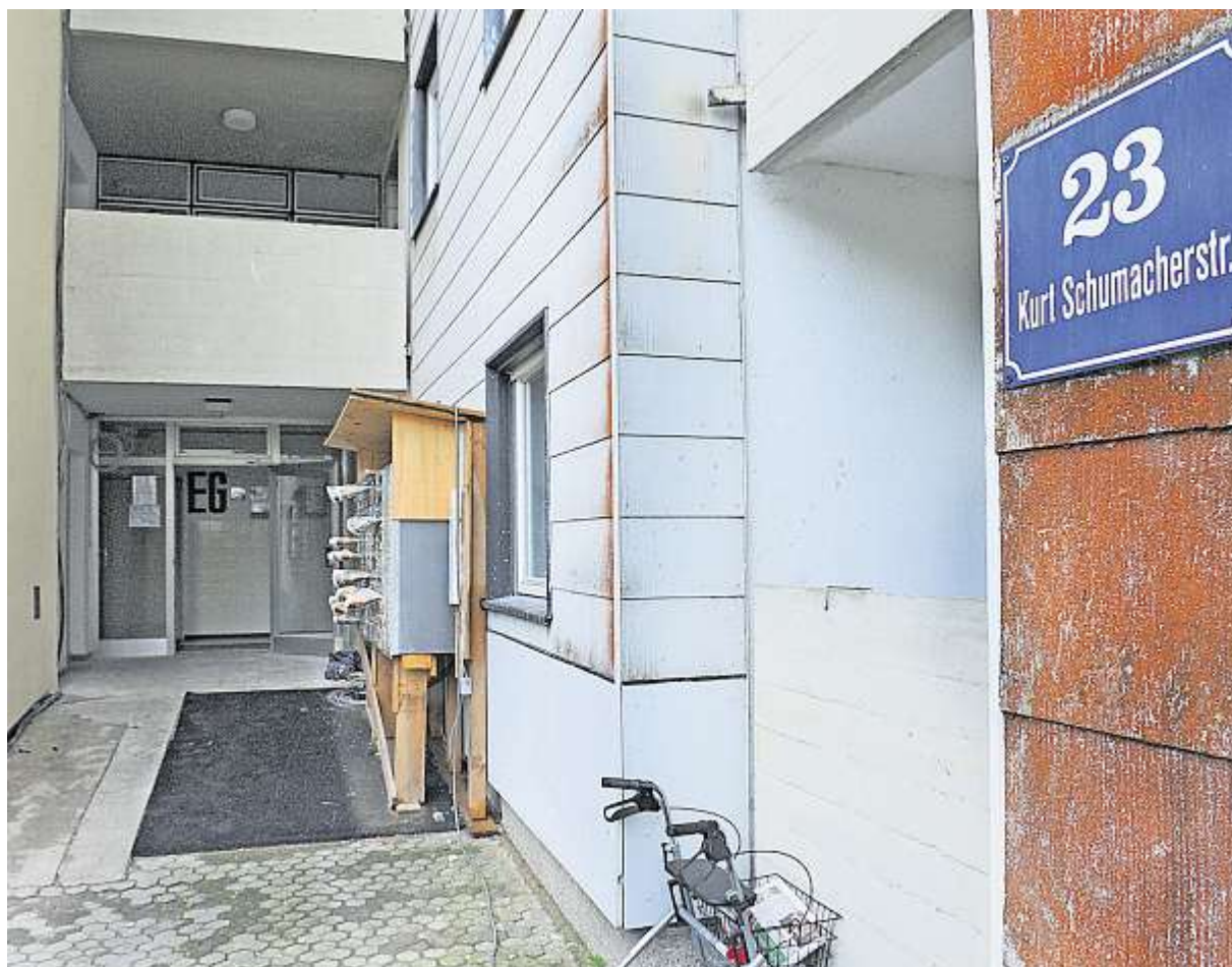
Die Kurt-Schumacher-Straße im September 2013: Mittlerweile hat sich viel getan. Der zweite Strang ist neu bezogen, der dritte wird gerade saniert. Auch die Wohnung des Ehepaars Steinbauer soll nun bald folgen. Foto: Archiv
