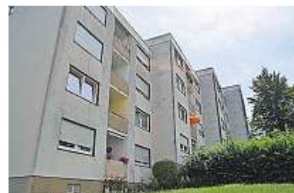
Das Haus Vitusstraße 12 ist laut Planung zum Abriss vorgesehen.
